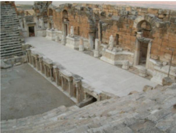
Il teatro nel 2007. Completamento del nuovo palcoscenico con una struttura pienamente reversibile. Le lastre di travertino sono posate secondo un disegno contemporaneo che interpreta quello antico, perduto; sono posate a secco su una struttura metallica appoggiata alle imposte degli archi sottostanti.
